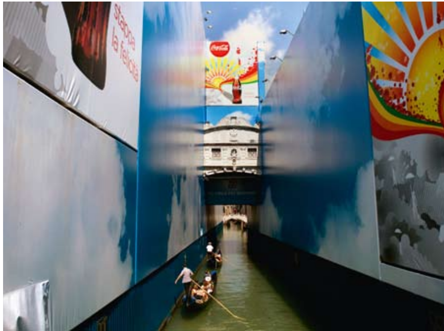
Antonio Politano Venezia. Ponte dei Sospiri tra i pannelli che mascherano i ponteggi sulle facciate in restauro di Palazzo Ducale e delle Prigioni Nuove, 2009.
