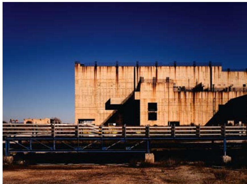
Gianni Galassi Montalto di Castro (VT). I resti della centrale nucleare. Nel 1988 si delibera di costruire, accanto all'edificio in disuso, un impianto termoelettrico, tuttora il più grande in funzione nel nostro Paese, 2010.
